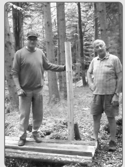
Josef Sperl und Friedrich Gasperlmaier beim Sanieren einer Brücke am Ritterweg.
